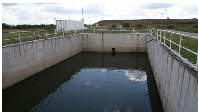
Figură VII.1.1.8Depozitul Regional Doba – bazinul colectare levigat
