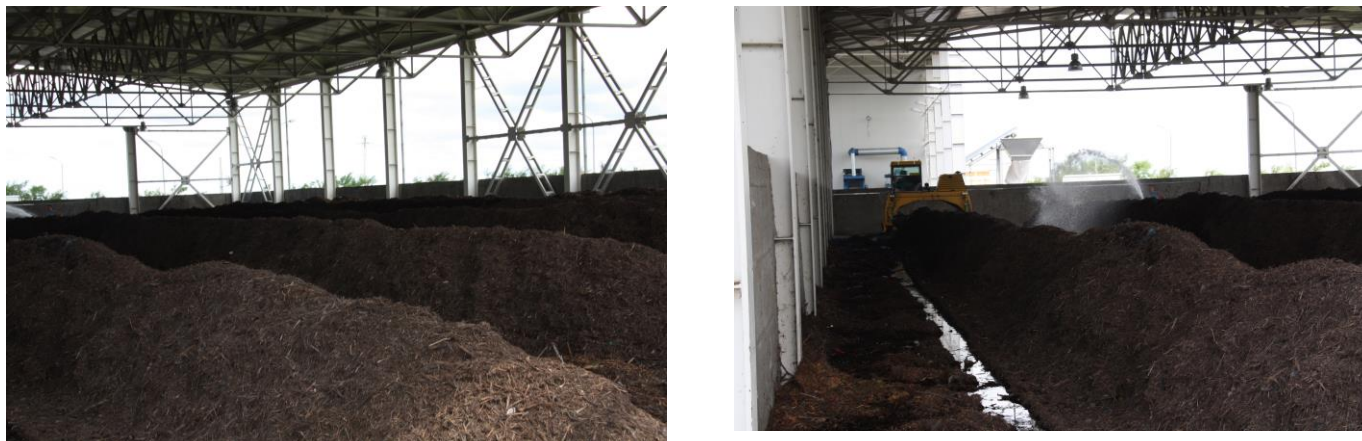
Figura VII.1.1.6 Stația de compostare Doba
