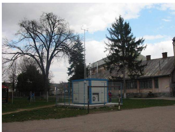
Figura 4.2.1. Stația de automată de monitorizare a calității aerului SM1
